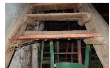
Απότομες σκάλες πατήματα χωρίς ρίχτια
