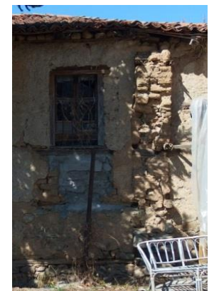
φωτογραφία 4 υπολείμματα τοίχου στην πίσω όψη
