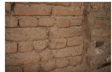
Τοιχοποιίες από πλιθάρια μείγμα από λάσπη αργίλου και άχυρο
