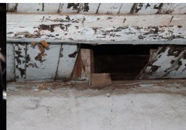
(5) Άναγμα στην οροφή, μέσω του οποίου γίνεται η πρόσβαση στην στέγη.
