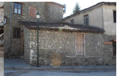
(6) Όψη λίθινης αποθήκης επί της οδού.
