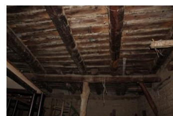
Ξύλινο δάπεδο Φέροντα στοιχεία οι δοκί κατά μήκος της μικρής διάστασης
