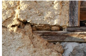
Γυδίες παραθύρων ξύλινες δοκίδες
