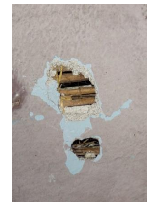
φωτογραφία 6 τοίχος από καλαμωτή
