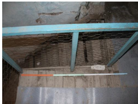
Μέτρηση μήκους κιγκλιδώματος
